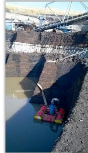
Nyíltvíztartás Maradó és csapadékvizek kiemelése
