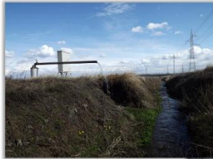
Ejtőkutas elővíztelenítés (haladó kútsoros) Fedő- és fekü oldali vízadók víztelenítése illetve feszültség mentesítése.
